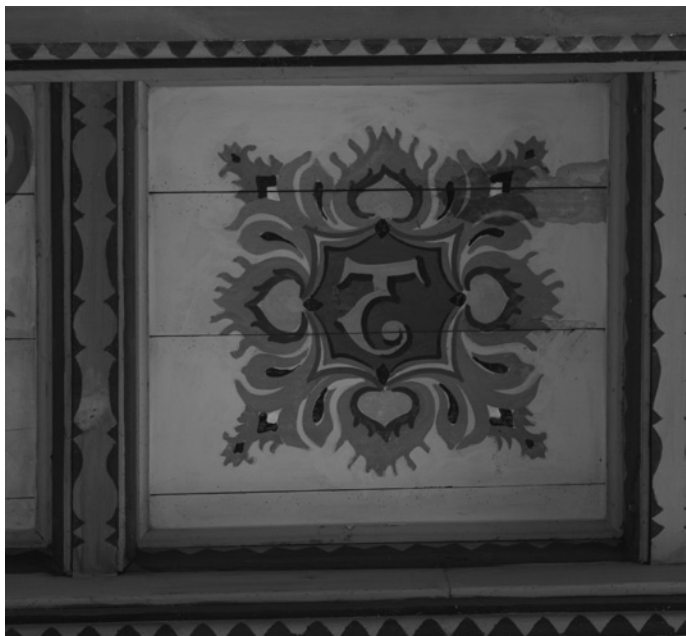
Podczas prac w latach 30. minionego wieku wykonano i przyozdobiło kasetony na sklepieniu w nawie głównej.
